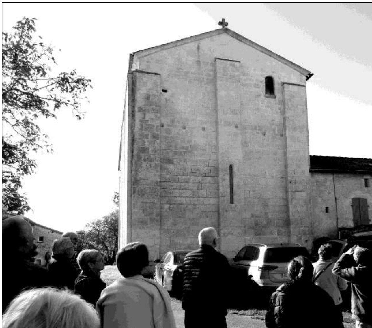
Bourg-des-Maisons côté est. En haut à droite ouverture d'une bretèche au-dessus de l'abside. (toutes les photos sont de Serge Laruë de Charlus ou de F. Gérard.)
