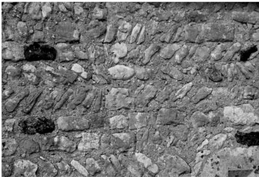
Bâti en petit appareil et 'arête de poisson' (opus spicatus) typique des églises carolingiennes (Montferrand-du-Périgord).
