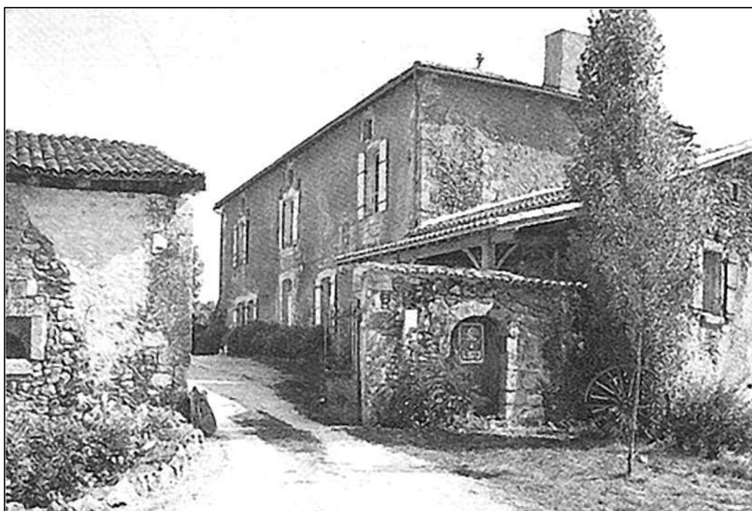
Maison des Pécon-Laugerie à Saint-Front sur Nizonne.
