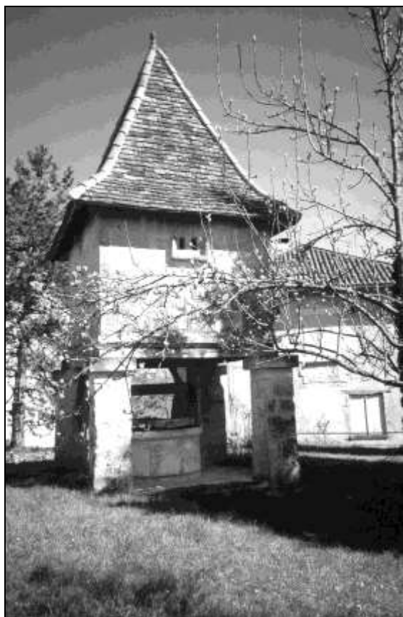
Pigeonnier modifié sur un puits couvert, vraisemblablement au 19 e siècle; Barneuil de Saint-Julien-de-Bourdeilles.
