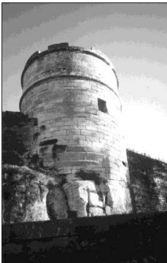
Le colombier-tour du château de La Gauterie de Saint-Pardoux-de-Mareuil.
