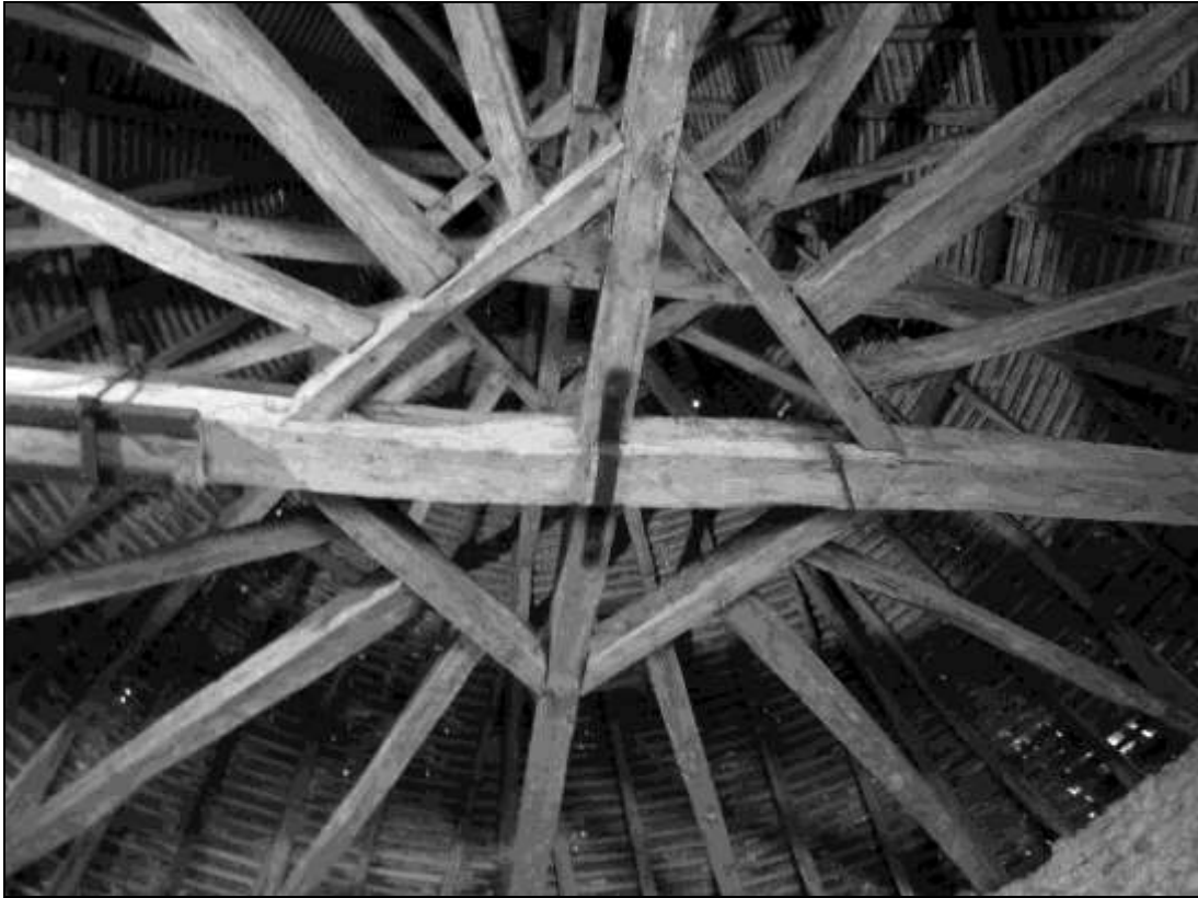
Charpente du colombier du Chapdeuil
