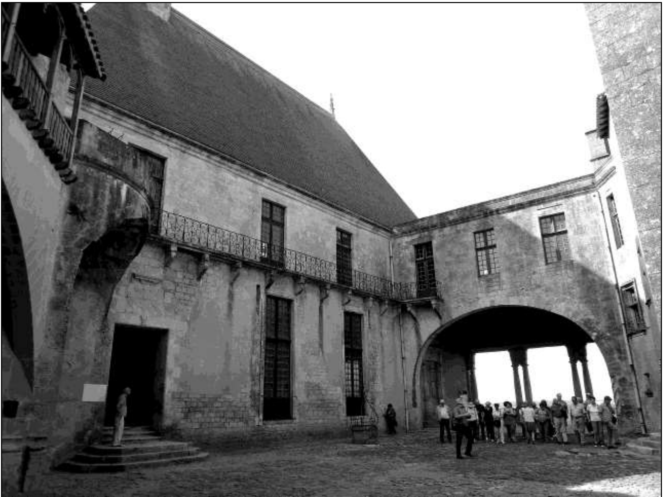
La partie moderne du château.
