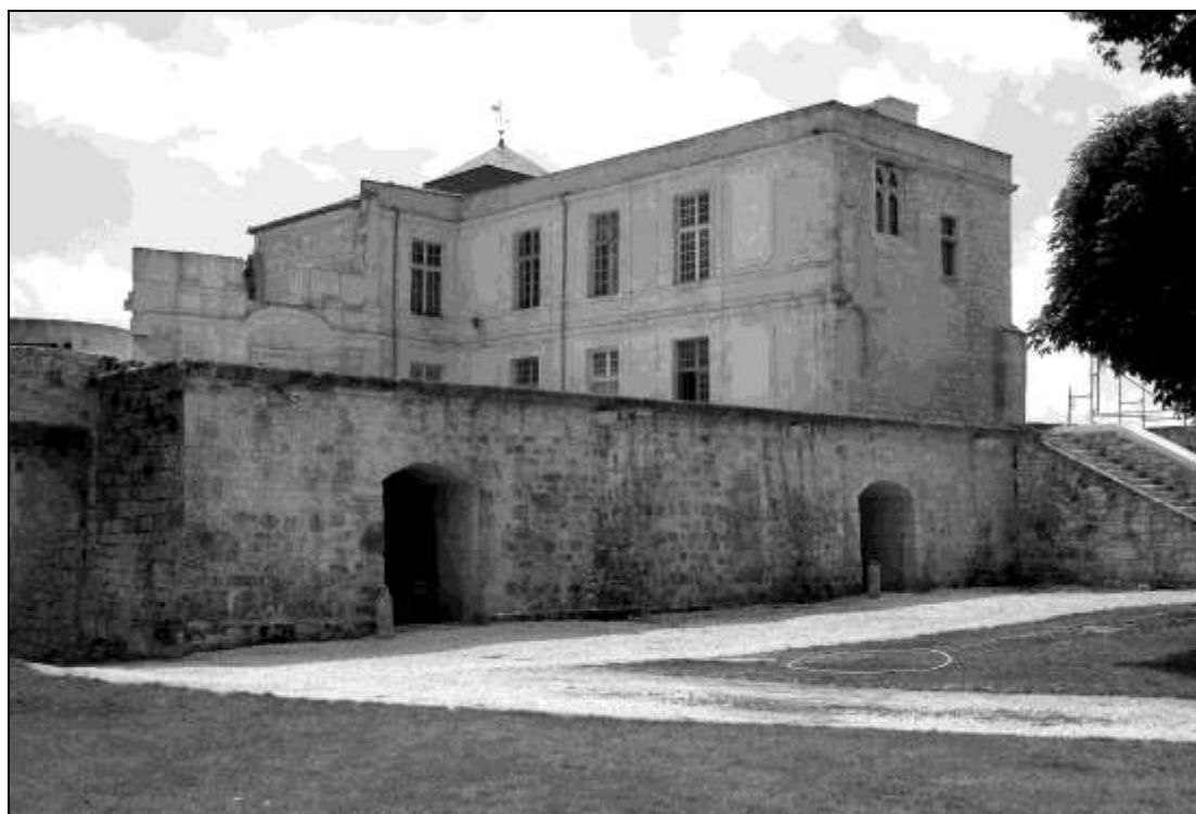
Aile ouest, sur le petit mur nord, on peut voir les anciennes ouvertures des XIIIe et XVe siècles.
