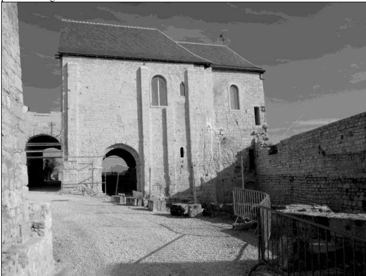
La chapelle restaurée.
