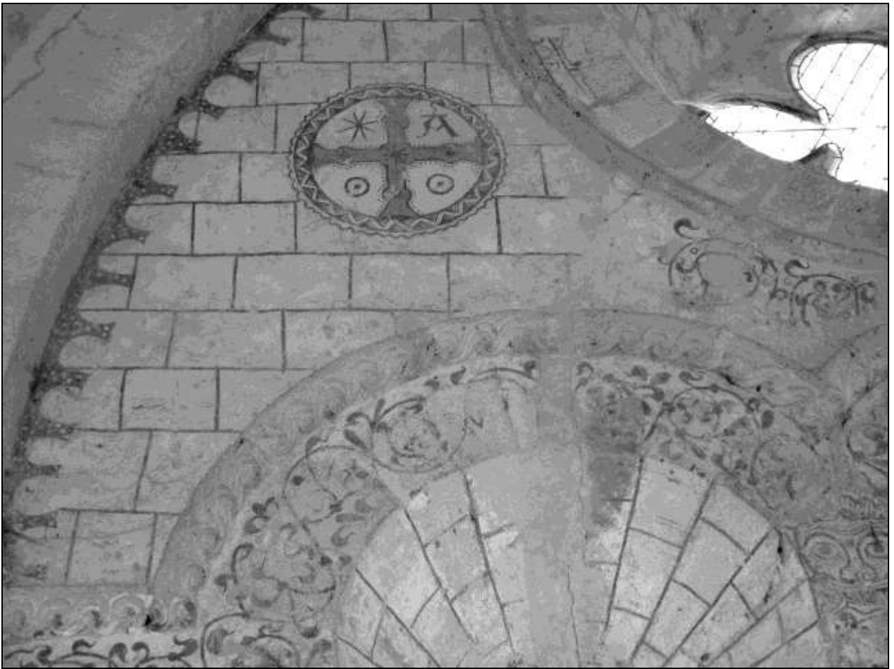
Détails du mur est.
