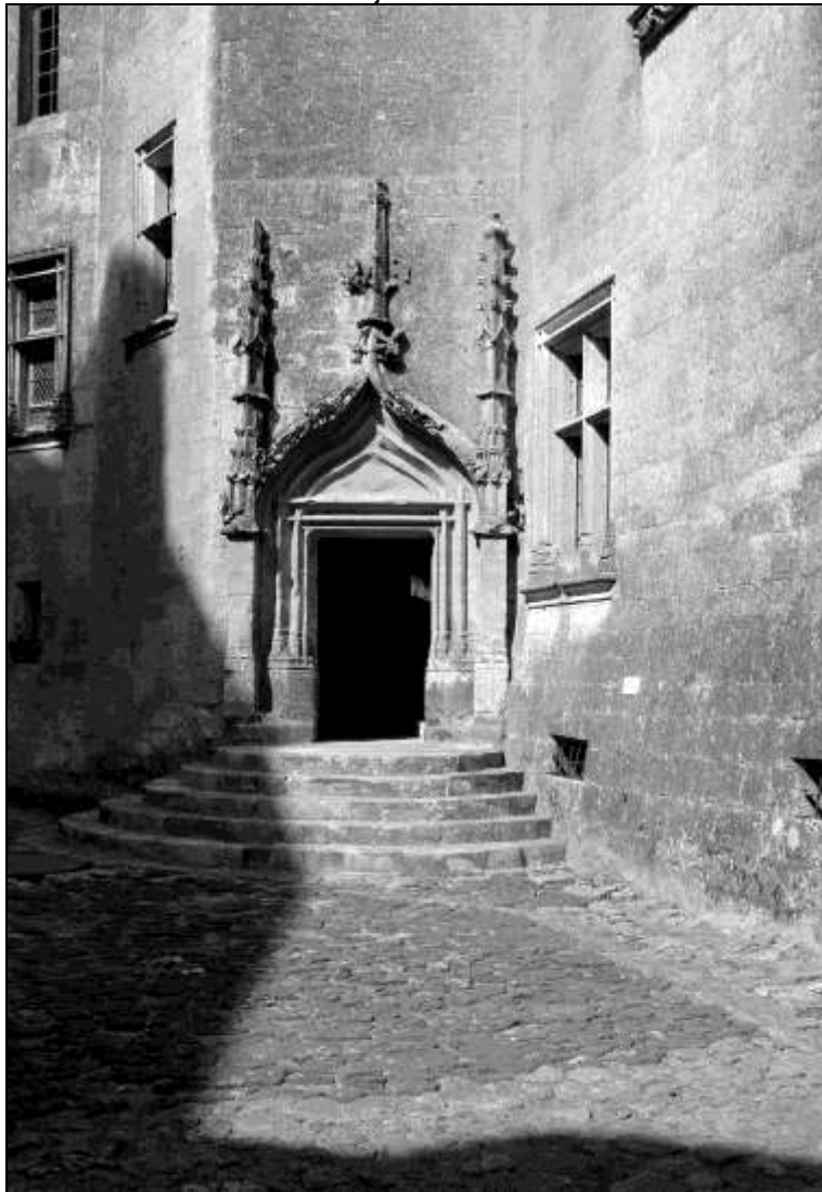
Entrée de la partie Renaissance.
