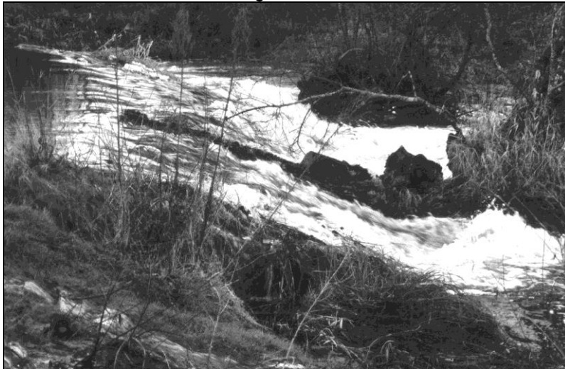
La chute d'eau du moulin de Chez Pey : le barrage sur le Bandiat retenait l'eau pour ce moulin qui avait deux roues.. Rénové dans les années 80, son propriétaire M. Laforge, faisait alors de l'huile de noix et participait aux journées des moulins organisées par l'association qui regroupe aussi Pinard, Javerlhac...
