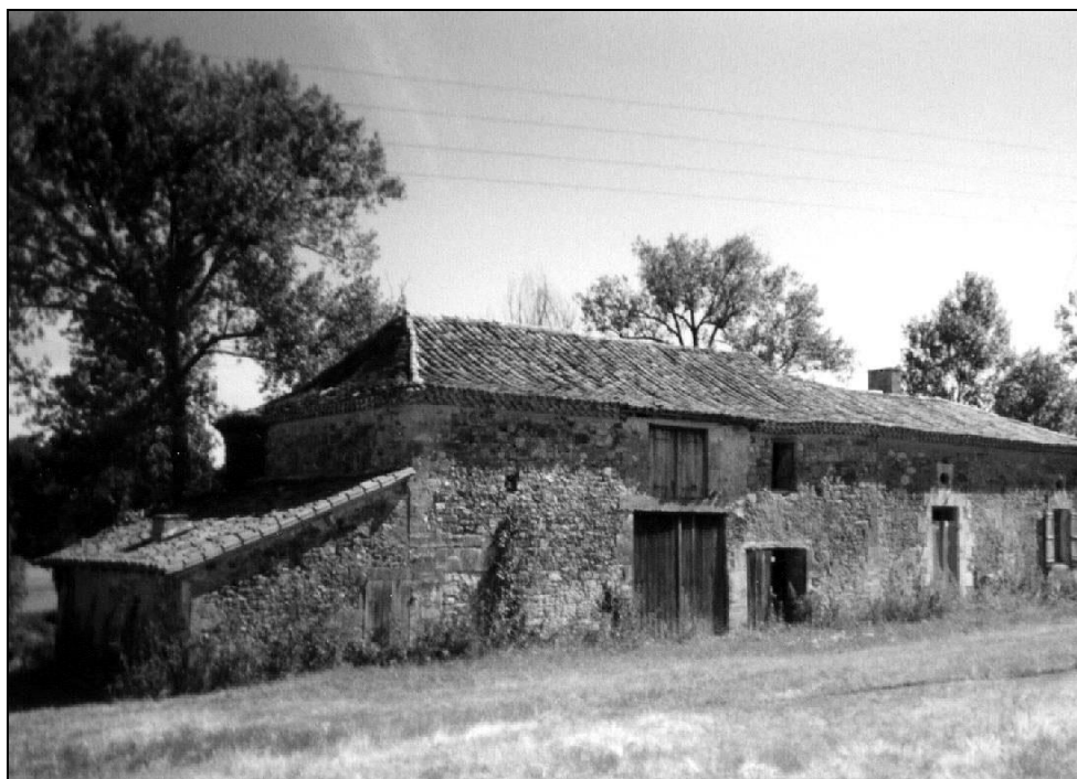
Toitures de tuiles 'canal'
