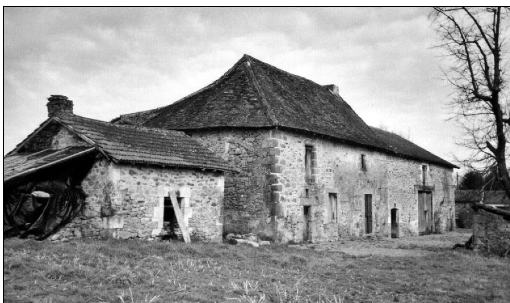
Toiture de tuiles plates.
