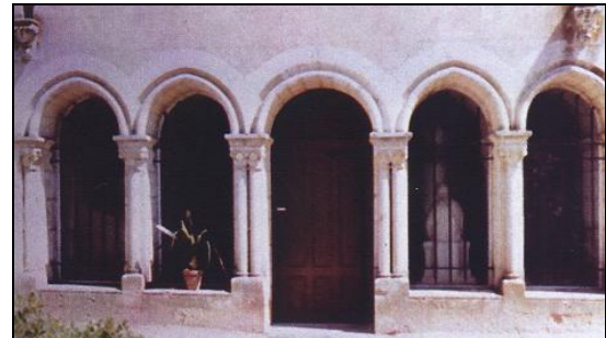
Salle Capitulaire, façade
